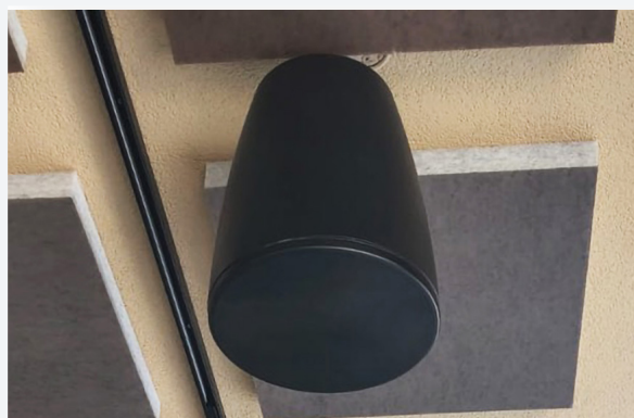
Sopra e sotto a sinistra - I dehors sono stati sonorizzati con cinque Bose Professional DesignMax DM6PE a sospensione, adatti a coprire ambienti con altezze importanti e superfici vetrate. Sotto a destra - Dettagli di un Bose Professional ArenaMatch Utility AMU208.
