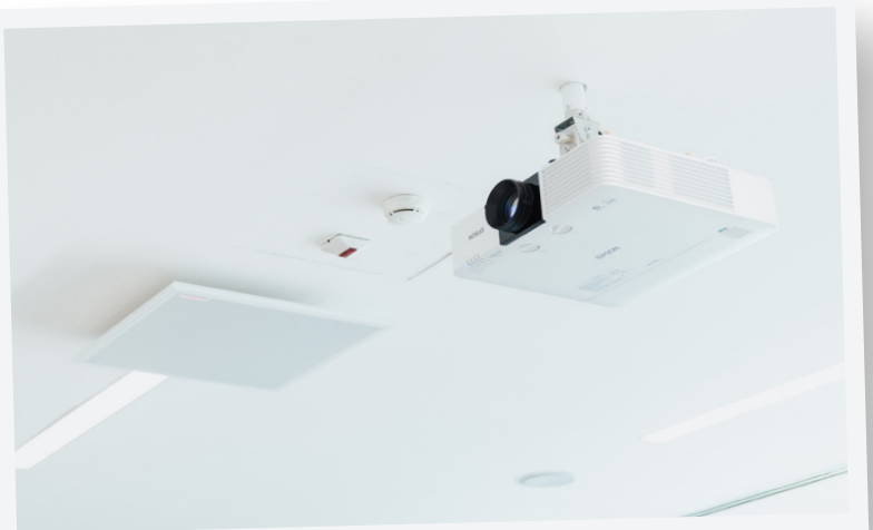
Uno dei videoproiettori Epson installati a soffitto nelle aule didattiche, modello Epson EB-L770U.
