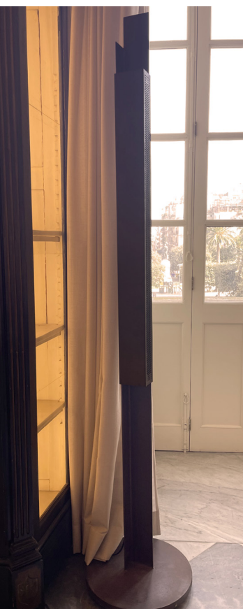
I diffusori array sono inseriti in totem anti-ribaltamento. Sono in corten come il manufatto centrale e si armonizzano perfettamente al contesto.
