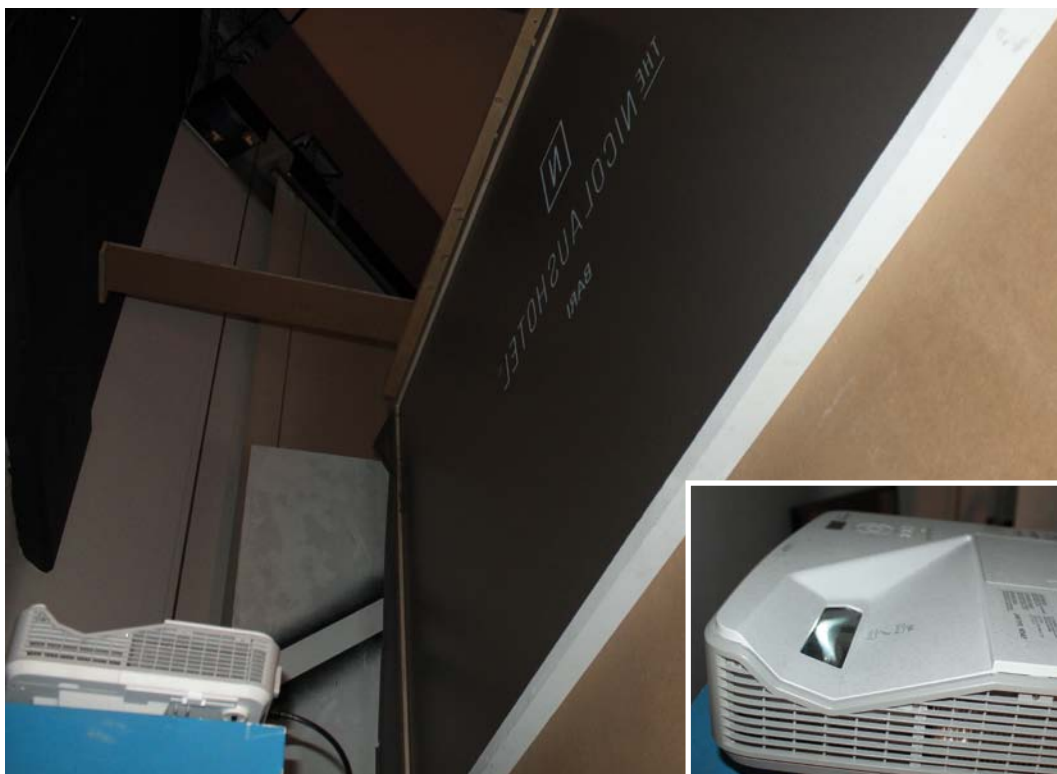
L'area dove sono stati installati i due NEC U321H, in retroproiezione sugli schermi laterali. Nel particolare uno dei due proiettori.
