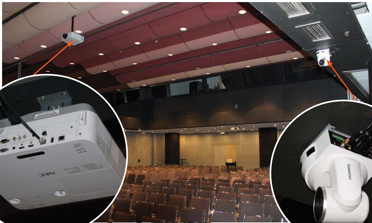
Panoramica della sala convegni; nei particolari il proiettore NEC PA803U, la camera PTZ Lumens VCG30 e, qui a destra, il suo controller.
