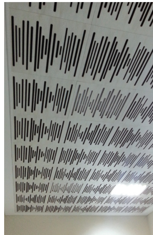
Risonatore membrana per basse frequenze.
