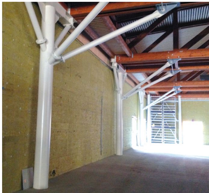
Parete fonoassorbitiva con membrane risonanti.
