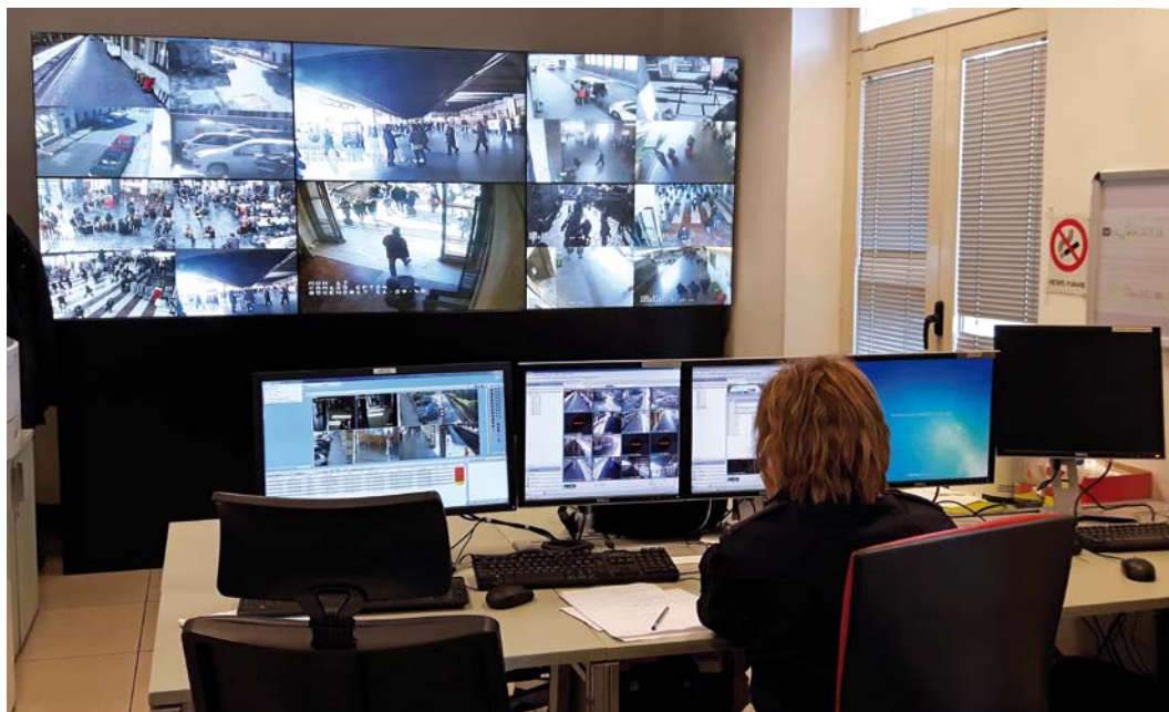
La Sala Operativa della Polfer a Firenze, stazione di Santa Maria Novella, con il videowall 3x2, composto da 6 monitor Panasonic TH-47LFV5W.
