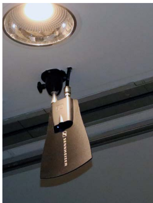
L'antenna attiva ricevente per radiomicrofoni Sennheiser, modello A3700.
