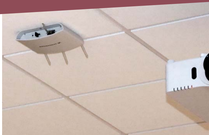
L'access point Wi-Fi per la rete di postazioni microfoniche wireless.
