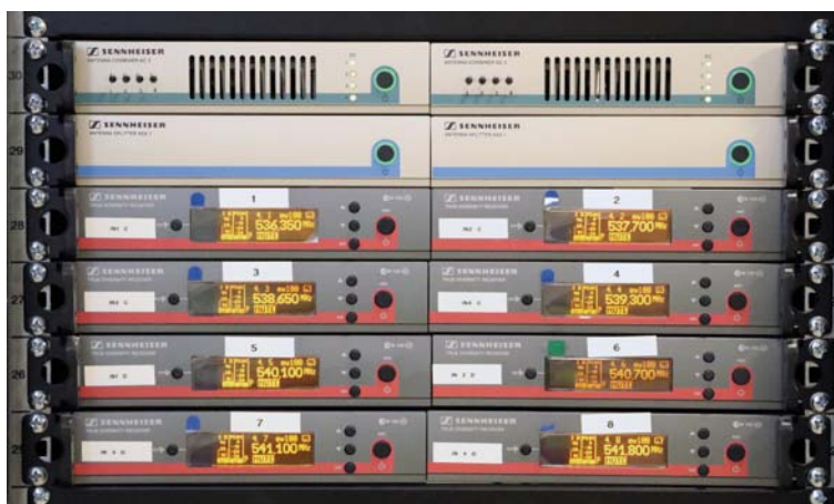
Particolare di uno dei tre rack regia con i ricevitori dedicati ai radiomicrofoni Sennheiser serie G3, a combinatori e splitter d'antenna.
