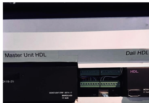
Sopra, la grafica realizzata per gestire audio, video e luci tramite il processore RTI XP-6S. A fianco, l'attuatore di HDL MC64-DALI.431, 64 canali.
