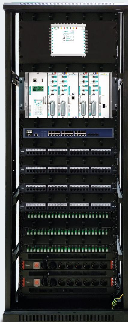
*Il rack dedicato alla distribuzione dei programmi in IPTV. I segnali ricevuti dalle antenne raggiungono un multiswitch (in alto nel rack) che consente a ciascun modulo della centrale 3DGFLEX (visibile sotto il multiswitch) di ricevere tutti i segnali, per poi selezionare quelli da distribuire nel Resort. Più in basso abbiamo gli switch della soluzione, con i 'master switch' intelligenti che garantiscono una gestione efficiente della banda.*
