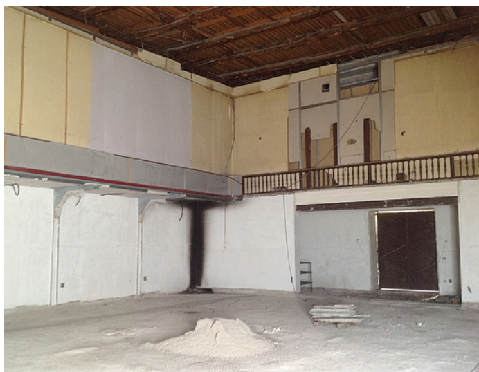
Uno scorcio della sala durante i primi giorni di inizio lavori.
